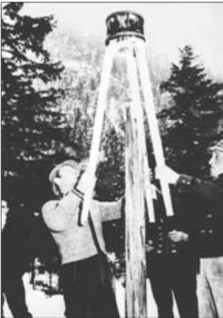
Photosammlung des Holzknechtmuseums Ruhpolding/Laubau: Gestellte Photographien zur Veranschaulichung der Arbeit von Holzknechten mit einer Handramme beim "Pfhlen" oder Pfostensetzen.
