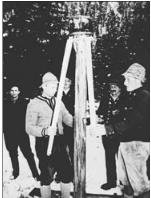
Photosammlung des Holzknechtmuseums Ruhpolding/Laubau: Gestellte Photographien zur Veranschaulichung der Arbeit von Holzknechten mit einer Handramme beim "Pfhlen" oder Pfostensetzen.
